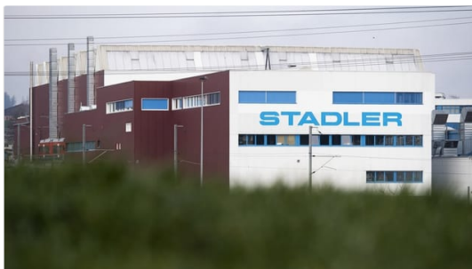
Auftrag aus Kanada Stadler Rail kann für 80 Millionen Franken Züge liefern
